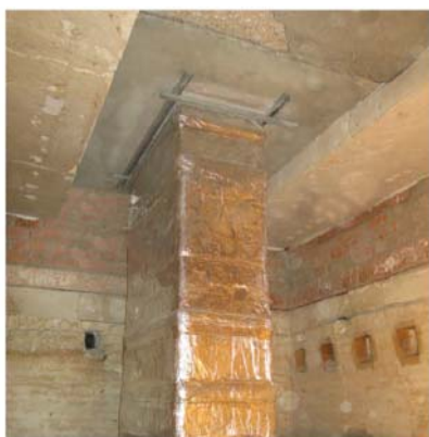
PARTICOLARE DELLO STAFFAGGIO A SOLETTA
