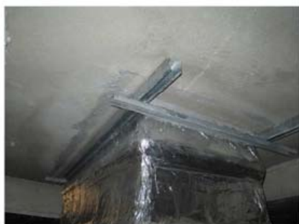
PARTICOLARE DELLO STAFFAGGIO A SOLETTA
