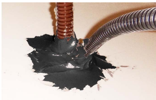
Esempio di attraversamento di corrugati protetti da ETS® SEAL-PRO
